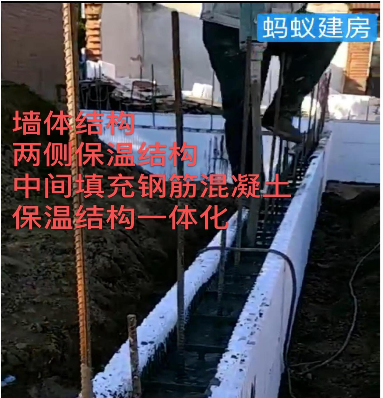
其次，空腔模块顾名思义，就是两层分别是 6cm 厚的保温板中间 13cm 是空心的，空心中间用钢筋混凝土浇筑，主体结构形成一体，即使八级地震来临也不会因为零散坠掉的墙体造成人财损失，因此非常结实，砖混结构的房屋坚固程度无法与之相比。
