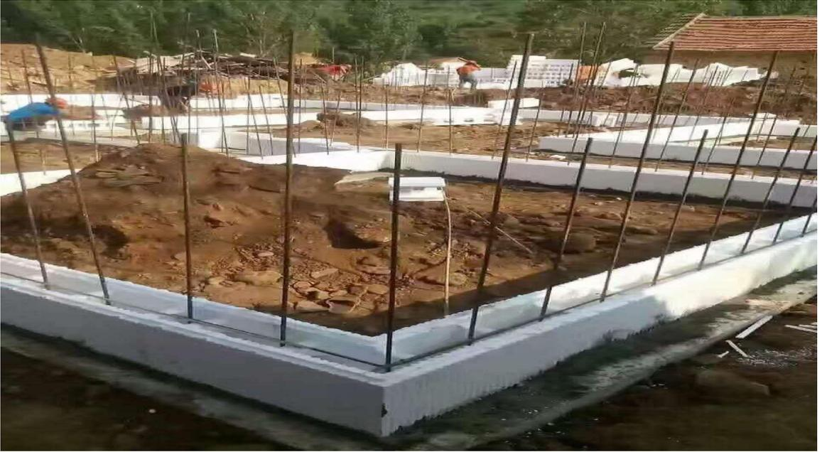
第一层摆放完毕，在聚苯模块中间，横向绑扎一道钢筋；门窗洞口需拼插堵头模块；摆放第二层的方法同第一层，使用小直角、小 T 型模块，与第一层错缝拼接；以此类推，顶面用专用护盖板或其他防护盖住聚苯模块企口，防止混凝土污染。
