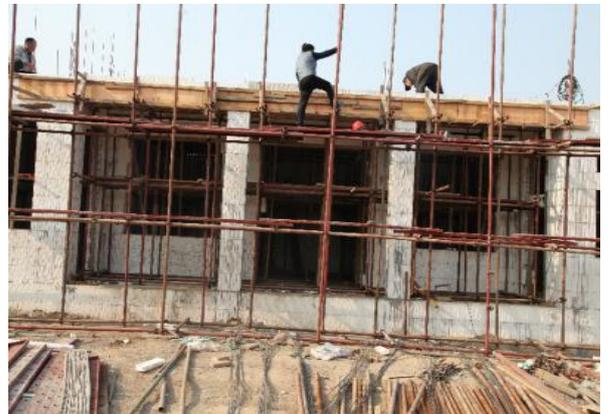
房屋为单层时，将墙体混凝土浇筑至檐口顶面，同时将固定屋架的预埋件校正；房屋为二层及以上时，将墙体混凝土浇筑至与楼面板下皮平行，支护楼板模板，绑扎楼面板钢筋，现浇混凝土；待混凝土凝固后方可进行二层墙体施工，工序同一层。
